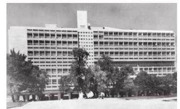
[192] Unidade de Habitação, Marselha
